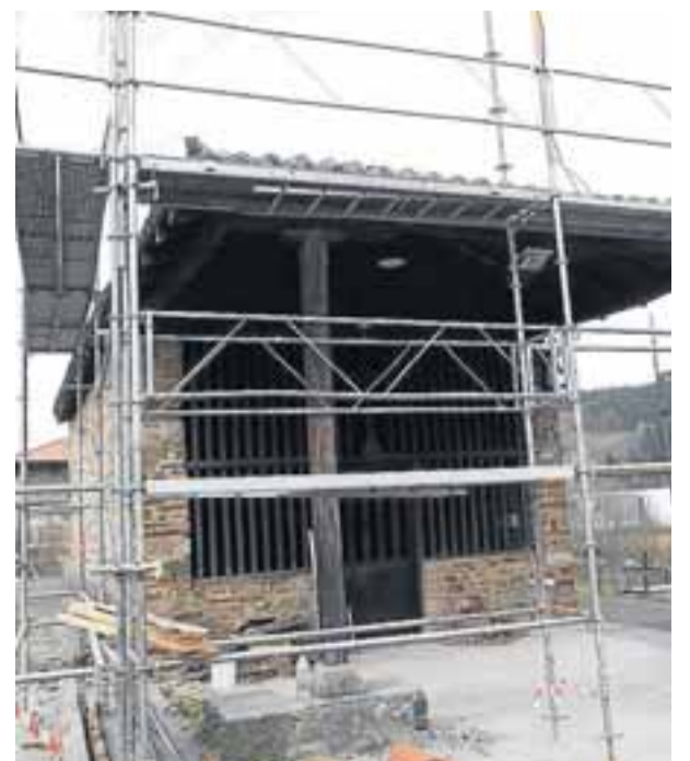
Estado actual de las obras. Foto: I. Ugarte
